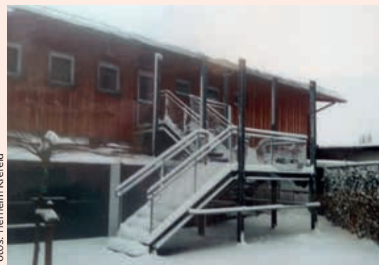
Neubau des Katzenhauses auf dem Dach des bestehenden Tierheims
